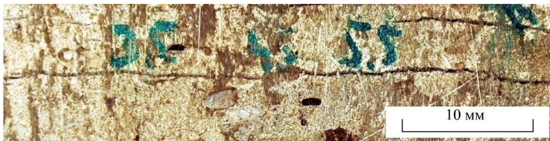
Рис. 5. Последовательное объединение трещин
